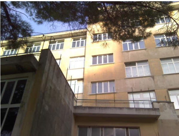
Figura 5: Muratura esterna Sud
