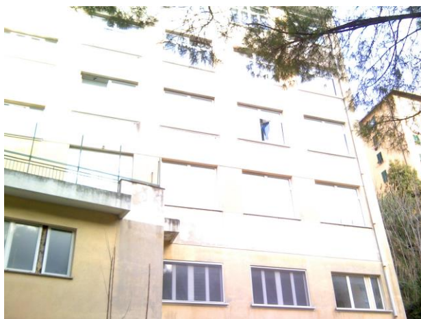
Figura 1: Muratura esterna Sud
